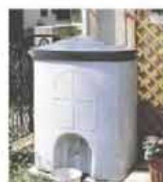
雨水貯留槽(一例)
