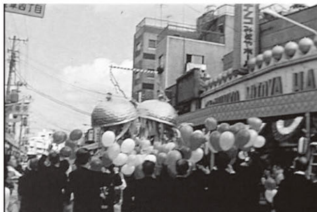
千束通り商店街アーケード完成（昭和50年）
