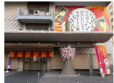
建物入口 (西側)
