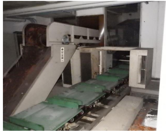
6階（旧区分機械室）
