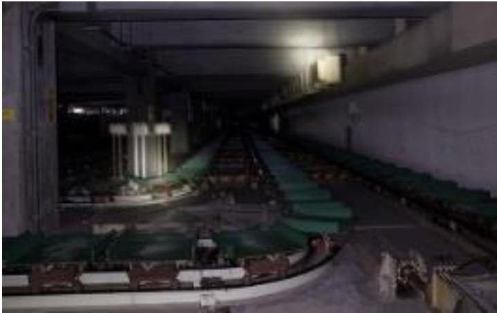
4階（旧区分機械室）
