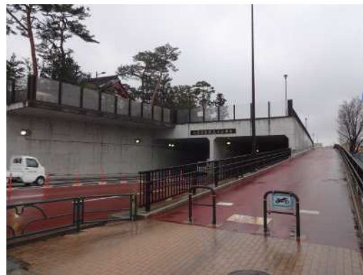
◇道路整備事業と連携した公園整備 (東伏見公園：西東京市)
