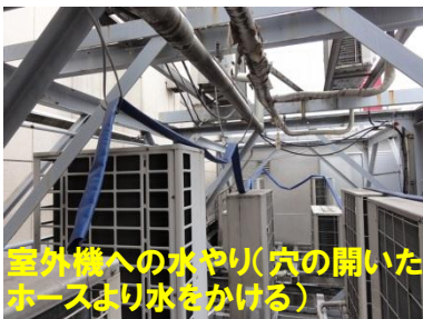
(参考) 室外機への水噴射前後の消費電力の変化
