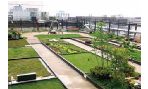
区役所の屋上緑化
