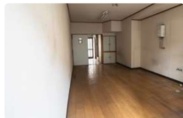
物件A：1階の様子
