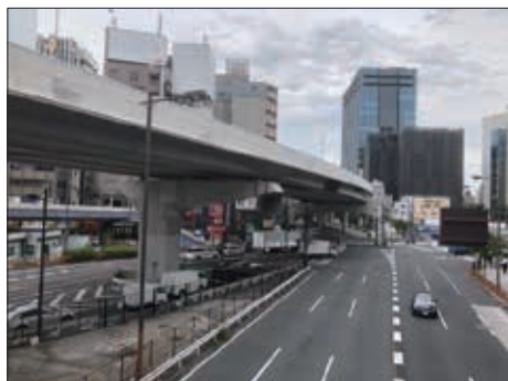
首都高速1号上野線と昭和通り
