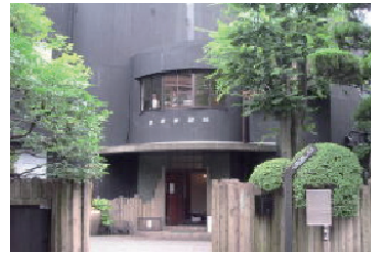
▲ 朝倉彫塑館 (登録有形文化財 [建造物])
