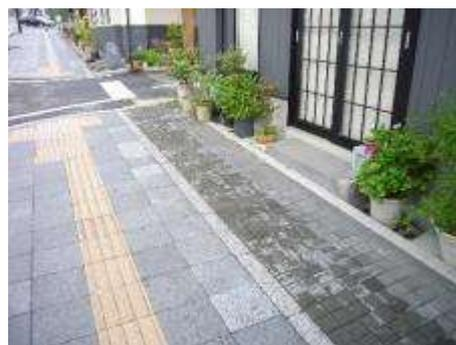
■ 通行車両の速度抑制を図っている例
