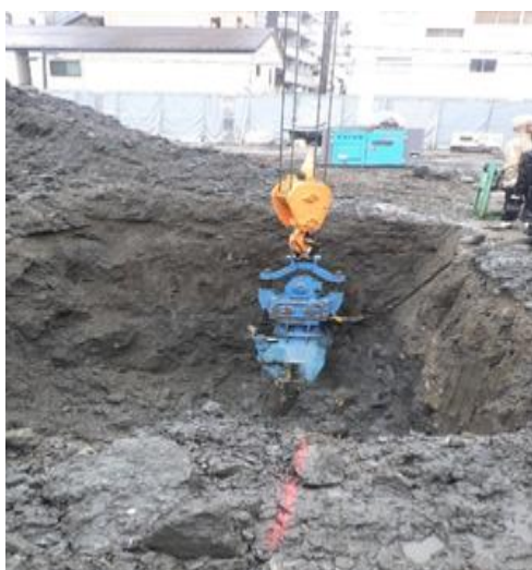
（令和7年12月24日 振動工法による施工）
