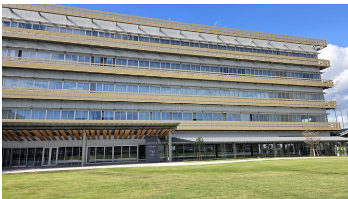
（伊丹市役所全景）
