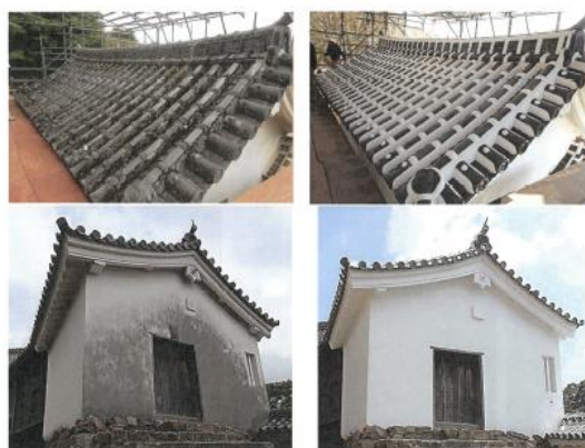
屋根・壁修理 左：修理前 右：修理後
