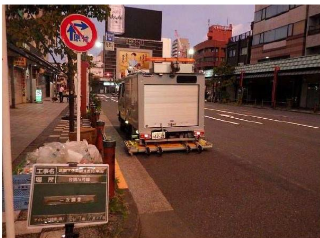
写真：探査車計測状況
