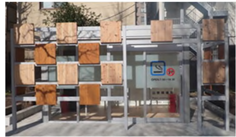
【整備例】金竜公園内公衆喫煙所
