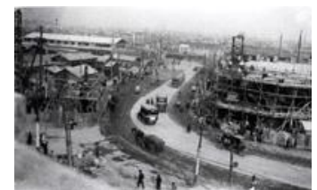
大正期の上野山下 (山手線高架工事 上野～神田間)
